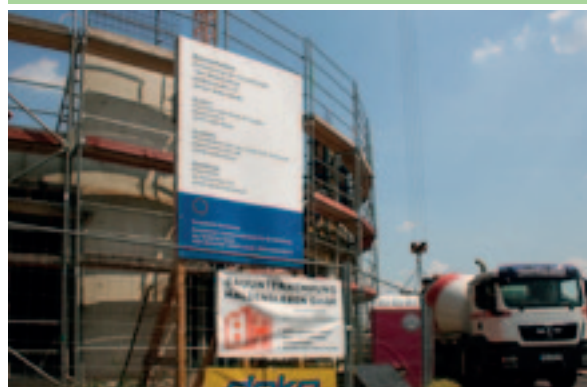
Baustelle Grundschule Niederndodeleben
