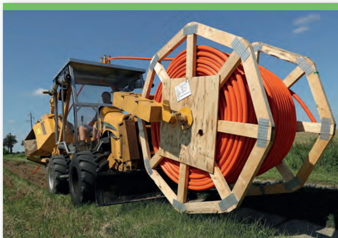
Breitbandkabel werden verlegt. Seit 2010 investierte die Gemeinde 1,8 Millionen Euro in das Breitbandnetz. Foto: MDDSL
