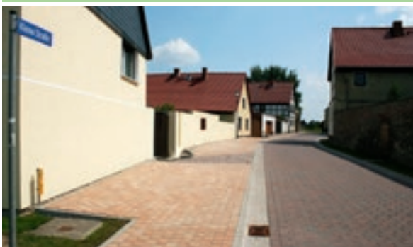
Umfassende Sanierung innerörtlicher Straßen und Wege im OT Wellen (Foto: W. Bock)
