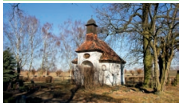
Sanierte Kapelle im OT Brumby (Foto: M. Schulz)
