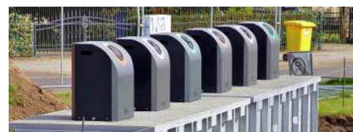
Im Olvenstedter Weg in Barleben entsteht eine weitere Unterflurcontaineranlage zum Sammeln von Altglas. Foto: Amann
